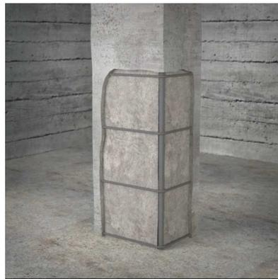
**Paso 4 - Recomposición con Mortero de Reparación**
