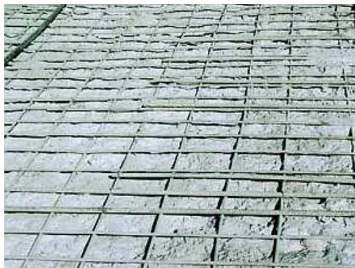
Armadura expuesta tras la hidrodemolición
