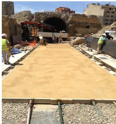
Los pavimentos estabilizados con Cal Hidráulica Natural y mezcla de áridos seleccionados y tratado de forma natural que le confieran unas propiedades adecuadas y constantes.
