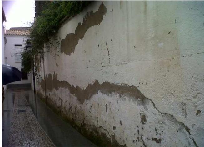
Se debe aplicar una primera capa de agarre de forma regular, con un espesor aproximado de medio centímetro, dejando una terminación rugosa. Después del primer endurecimiento, se aplica el mortero porógeno por capas de unos dos centímetros cada una, hasta obtener un espesor final de entre dos y cuatro.
