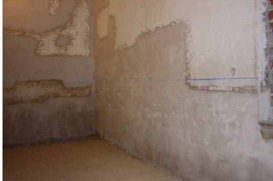
Una vez limpio, lavar de nuevo ahora ya solo con agua hasta que el soporte se sature y esperar a que se absorba bien el agua, hasta la desaparición del brillo superficial, antes del siguiente paso.
